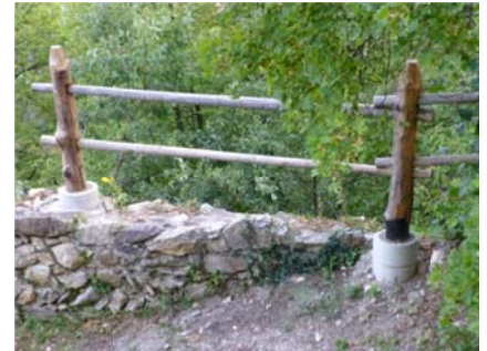
„Kanalrohr“-Zaun in der Burgmauer
